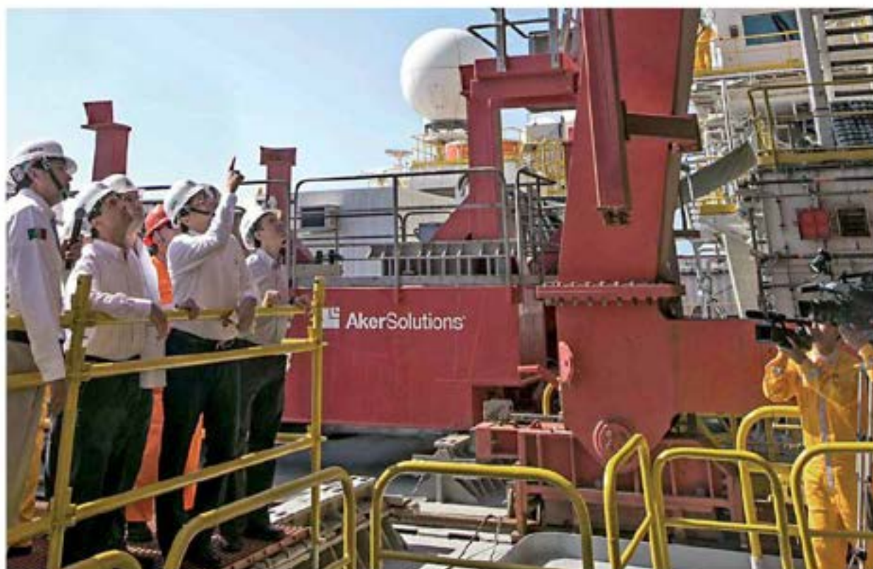
Recorrido por la plataforma Centenario GR, ubicada en el Golfo de México.
